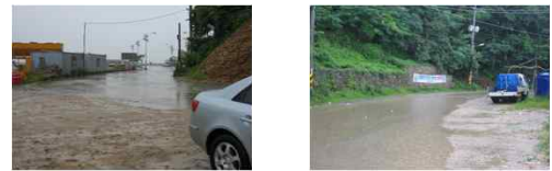
[그림 4] 삼길포항 건설 공사 현장
