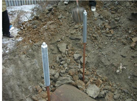
그림 5. Thermal siphon 설치작업
