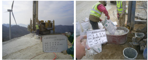
(a) 접지봉 매설 (b) 접지저항제 타설 <그림2-7> 보링 접지공사
