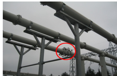
<그림 3> 다양한 위치에 설치된 벨로우즈
