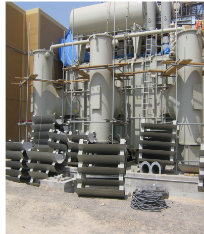
<그림 11> 400kV XLPE 630SQ 광복합 유중 종단접속함 시공
