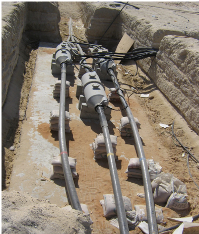
<그림 9> 400kV XLPE 630SQ 광복합 조립식 접속함 시공
