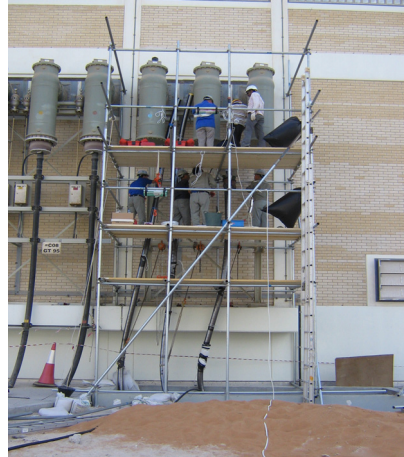
<그림 11> 400kV XLPE 630SQ 광복합 유중 종단접속함 시공
