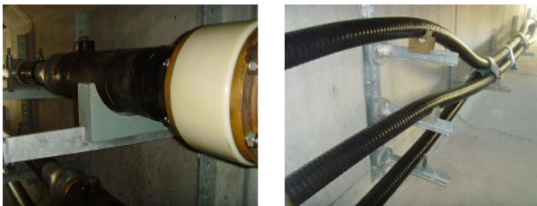
(a) 접속함 구간 (b) 오프셋 구간 <그림 5> 케이블 삼상단락 시의 포설구간별 전자력 궤적
