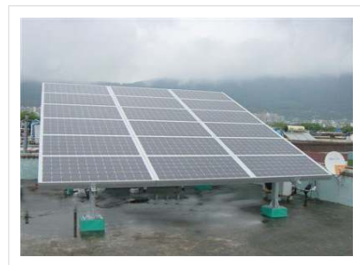
그림 4 설치 사진 Fig. 4 Installation Picture
