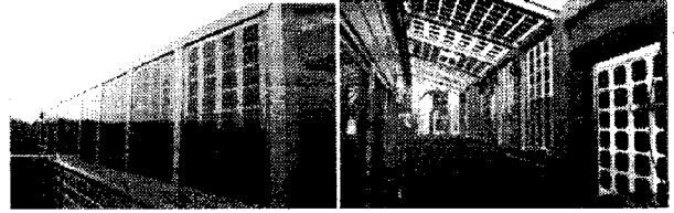
그림 4. PV 모듈의 설치 전경
