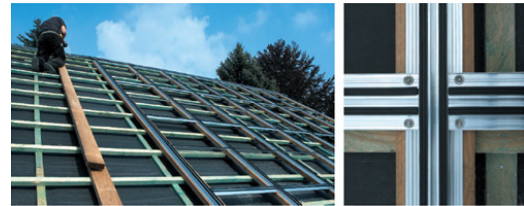
Fig. 3 지붕 마감 후 모듈 고정위한 프레임 설치
