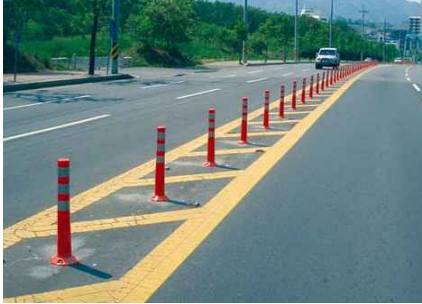
〈그림 1〉 시선유도봉의 설치 및 파손 예시
