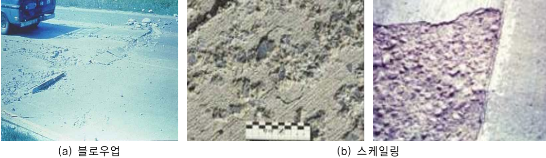
<그림 7> 탈리 형태(FHWA, 2003, Distress Identification Manual)
