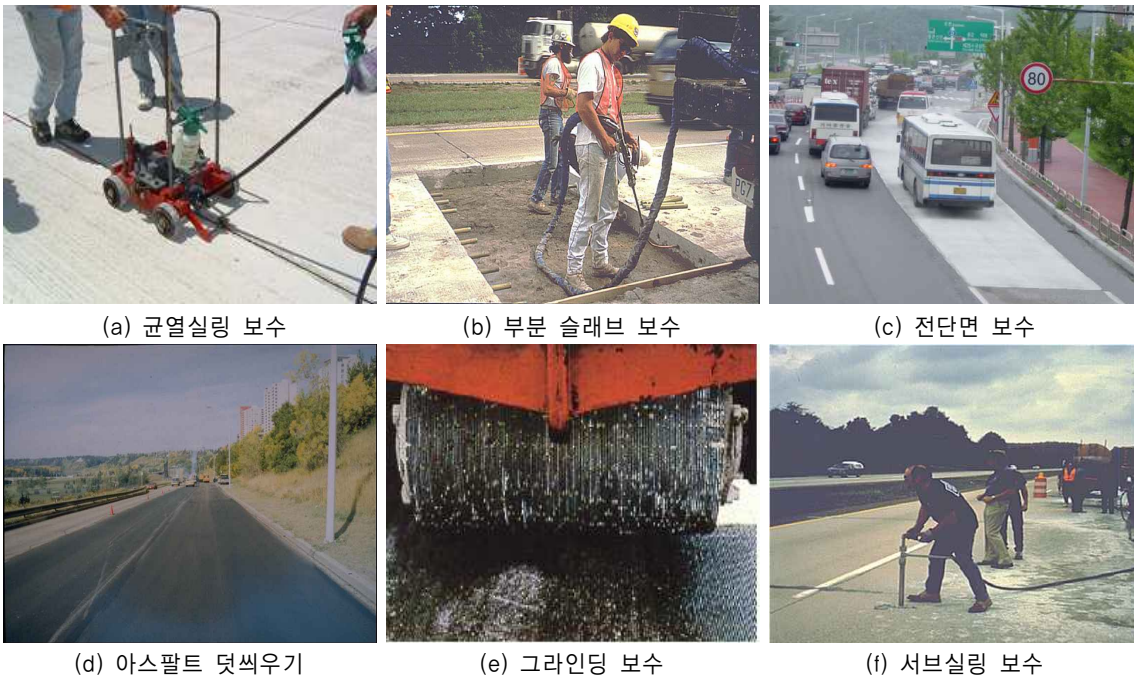
<그림 9> 시멘트 콘크리트 포장의 유지보수공법
