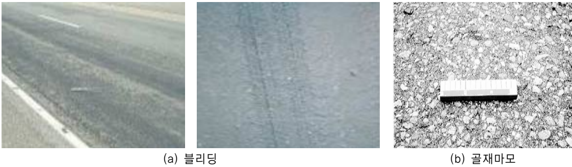
(a) 블리딩 (b) 골재마모 <그림 4> 미끄럼 저항 감소 형상(FHWA, 2003, Distress Identification Manual)
