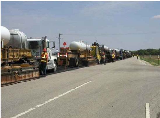
〈그림 1〉 현장 가열 표층 재생공법 현장 (아이오아 2006)
