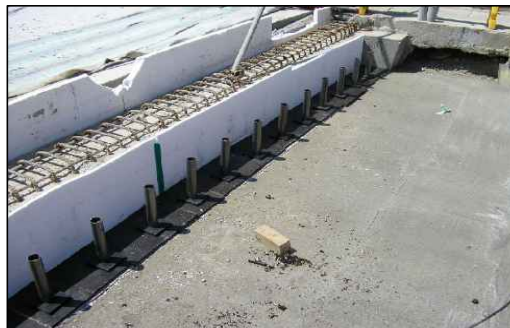
<그림 1> 교대와 접속슬래브의 접합부 시공현황
