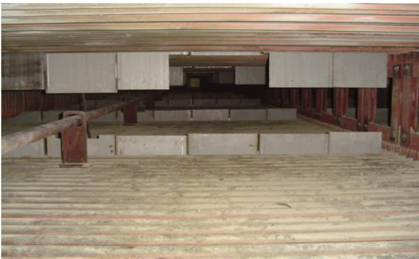
Fig. 19는 현 보일러 모델에 Anti-Noise Baffle을 장착한 후 보일러를 부하 0에서 800MW까지 상승시키면서 보일러 Backpass의 소음 공진 현상을 나타낸다.
