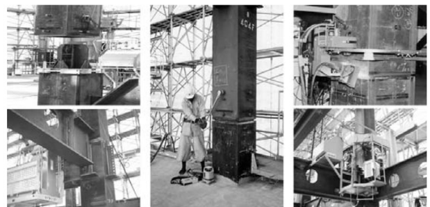
(a) 각형강관의 가조립 (b) 수직도 조정 (c) 용접로봇에 의한 용접
