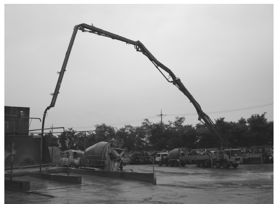
사진 2. 고강도콘크리트 펌프압송 시험 장면
