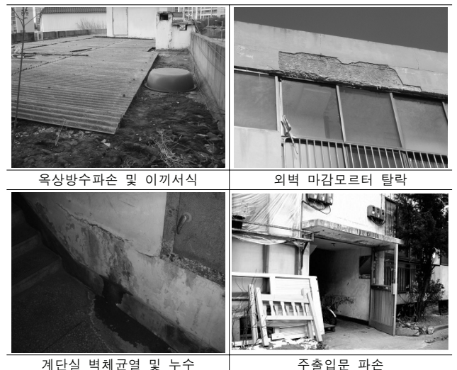
그림 3. 건축마감분야 주요결함 사진
