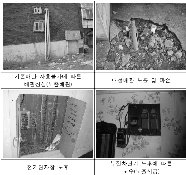
그림 4. 설비노후도분야 주요결함 사진
