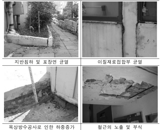
그림 2. 구조안전성분야 주요결함 사진
