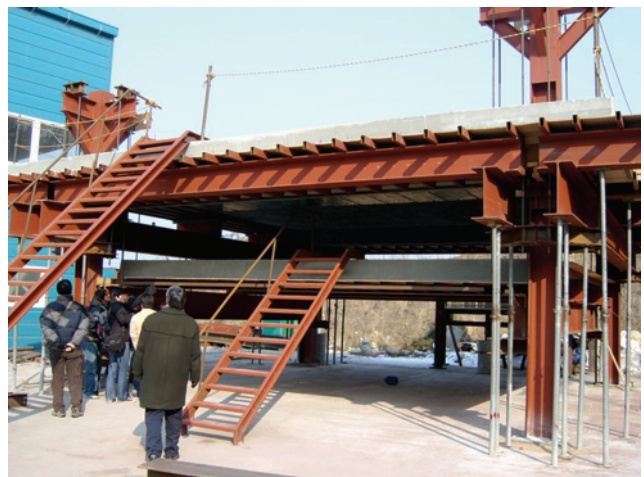
그림 3. 지하 역타 공법용 상·하 분리형 무지주 지지체 시험 시공 장면
