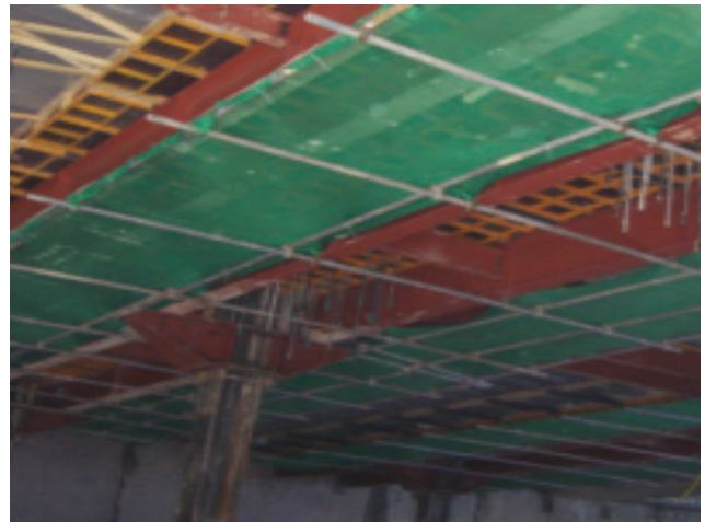
그림 2. BRD 공법 시공 장면
