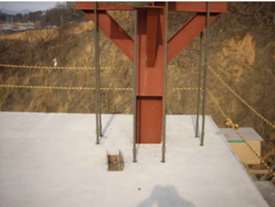
c) 제1현수재 연장 및 하강기 해제 그림 6. Mock-up Test 장면
