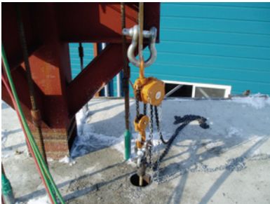
a) R/C 슬래브 타설·양생 및 하강기 설치
