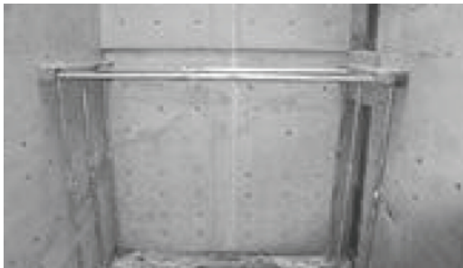
사진 3. 시스템 서포트 설치 사진
