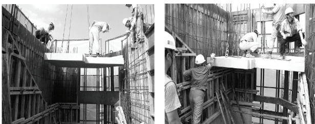
(a) 벽체 거푸집 설치 (b) PC 참의 설치
