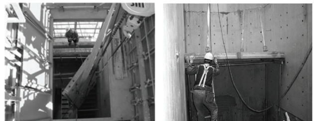
(a) PC 참의 코어 내 반입 (b) PC 참의 설치
