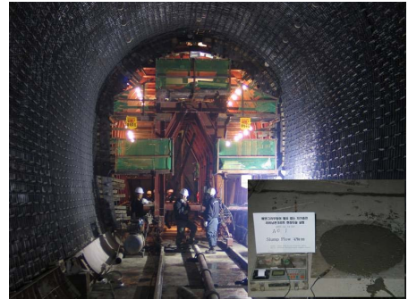
그림 2 고유동 콘크리트 타설 (인천공항 철도 라이닝 콘크리트)
