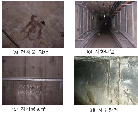
사진 1 콘크리트의 외관 상태
