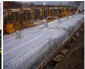
사진 4. 버블시트 시공전경
