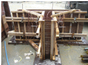
그림 5 T형 거푸집(Mock-up Test)
