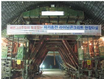
그림 1. 타설 현장 전경
