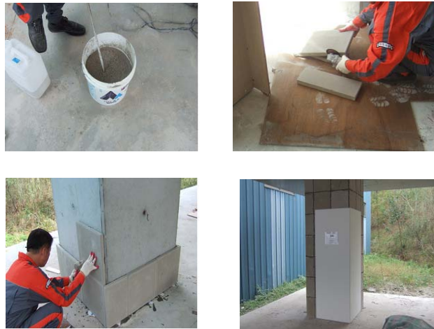
그림 6. PFB 공법 현장 시공
