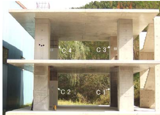
그림 1 Mock-Up 시공 현황
