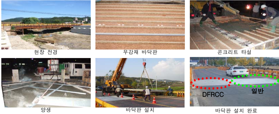
그림 2 FRP-DFRCC 합성 바닥판의 현장 적용
