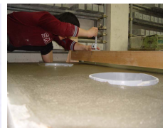
사진 2. 표면 마감 후 침하깊이 측정
