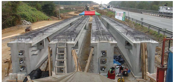
그림 2 거더 제작 후 모습
