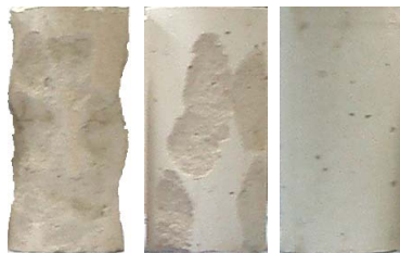
(a) PCM (b) FRC (c) FR-ECC 그림 2. 폭렬 및 균열 발생상황
