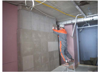
그림8 습식 PFB 공법 시공 현황
