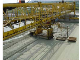
사진 1 LMC 포설 후 마감
