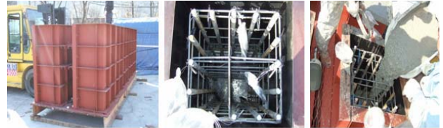
시험체 몰드 철근 및 sensor 설치 콘크리트 타설
