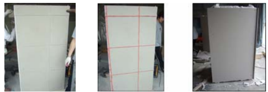
(d) PF보드설치 (e) 이음세보강 (f) 석고보드 시공
