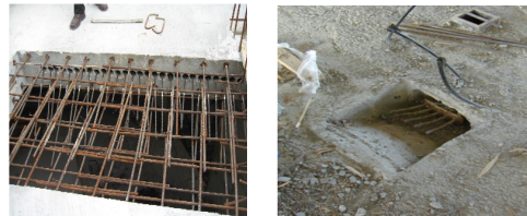
(a) 내부 측면 긴장방식 (b) 내부 상향 긴장방식 그림 1. 슬래브 내부 긴장 방식의 종류
