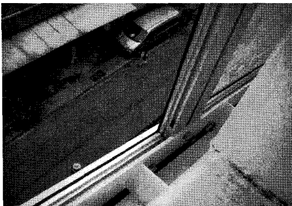
그림 14. 강관프레임과 ETFE 정착 디테일 (사진)
