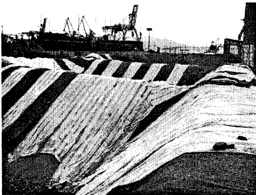
그림 8. 흙둑 설치 전경
