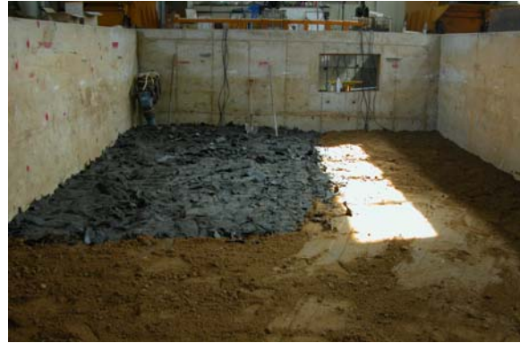
(b) 단면 I, II 시공 장면
