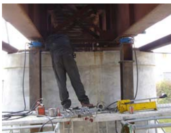
(a) 동바리, 작업대 설치
