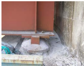
(b) 받침 콘크리트 파쇄
