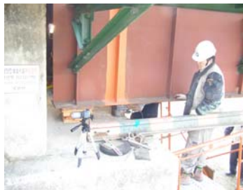
(a) 잭 설치
