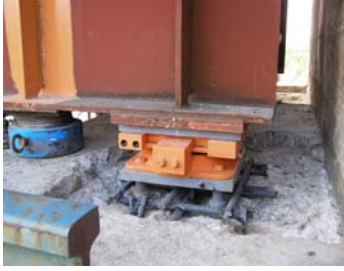
(d) 신설 교량받침 설치
