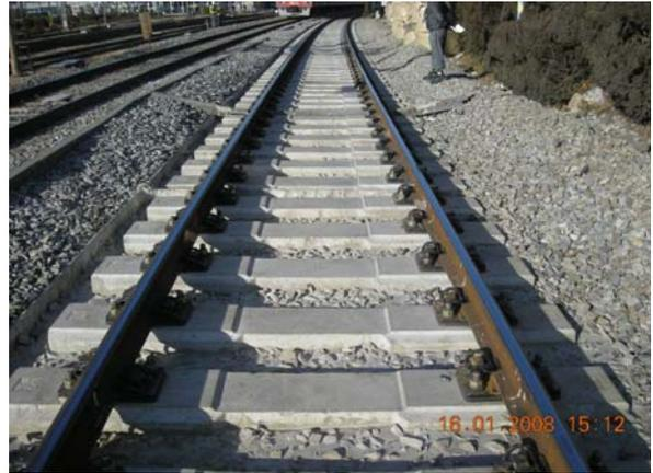
그림 10. 표면폐쇄형 포장궤도(급곡선용 침목구간) 그림 11. 표면노출형 포장궤도(표준침목 구간)
