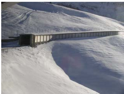
그림 2. 융후라오 산악철도에 설치한 눈사태 방지용 지붕
