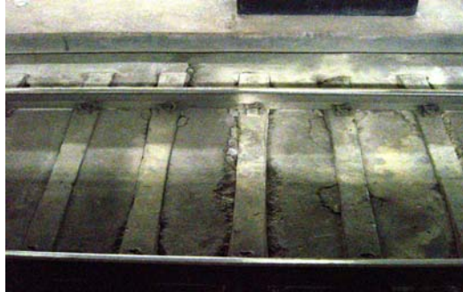
그림 1. 패드탄성 부족으로 인한 손상사례
