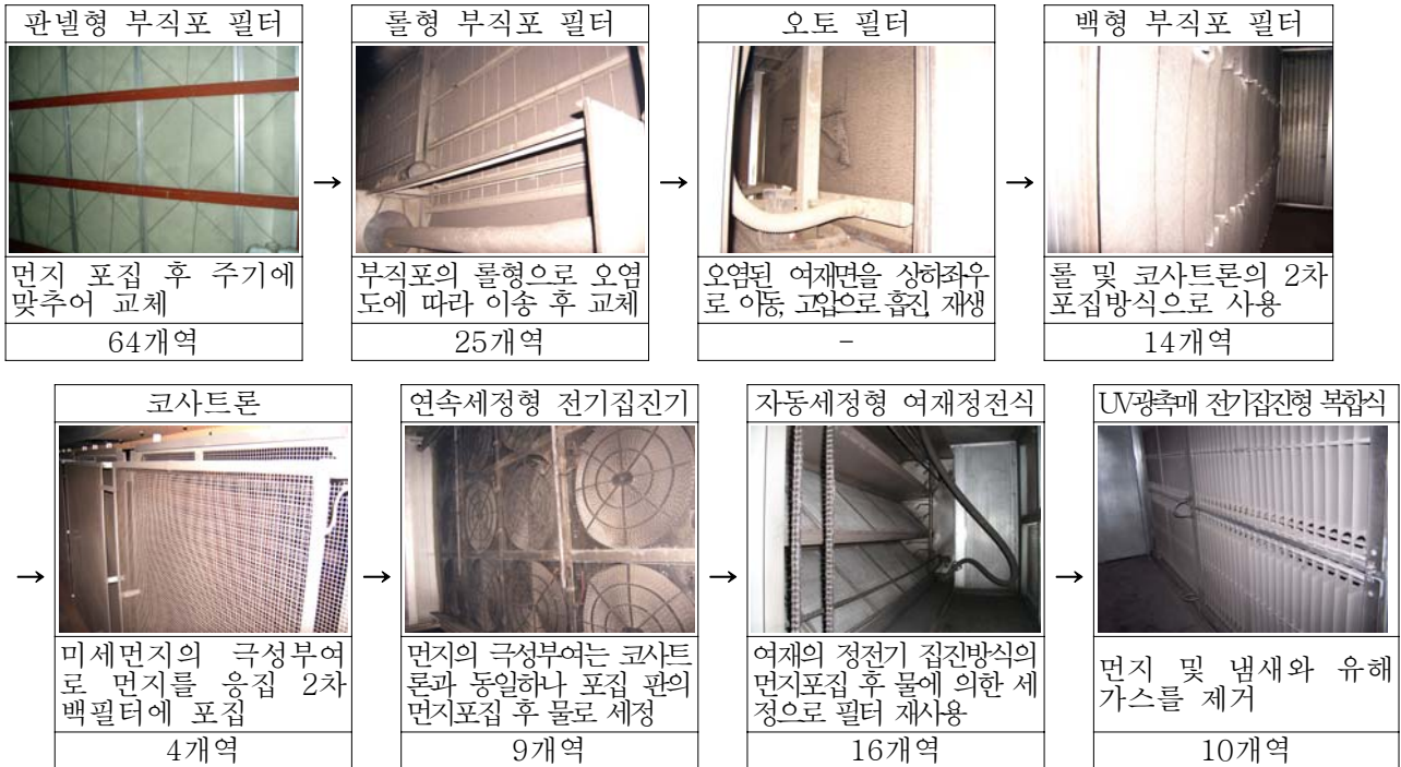
그림3. 서울메트로 에어필터 시스템 변천
