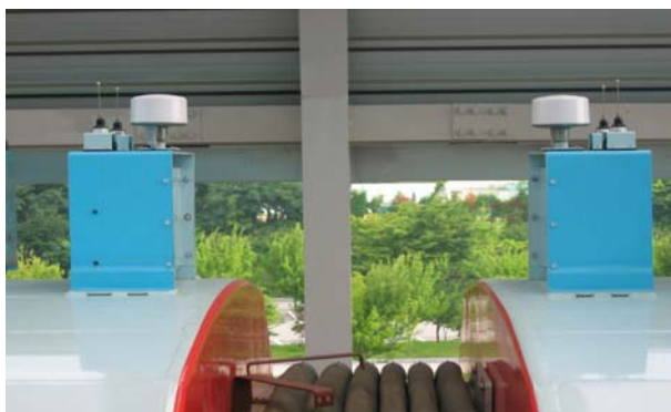
사진4. 차상 WLAN 안테나 설치 상태
