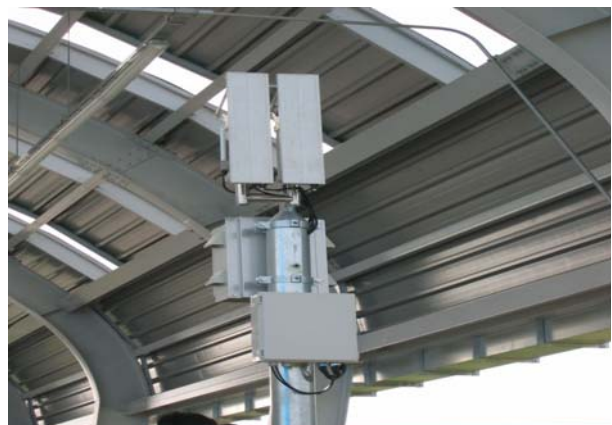
사진5. 지상 AP 안테나 설치 상태
