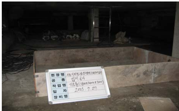
그림 2. 탄소접지봉 스테이션 기초 틀 공사
