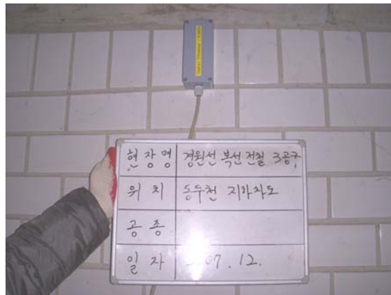
그림 5. 경원선 철도구조물 현장에 설치한 경사계
