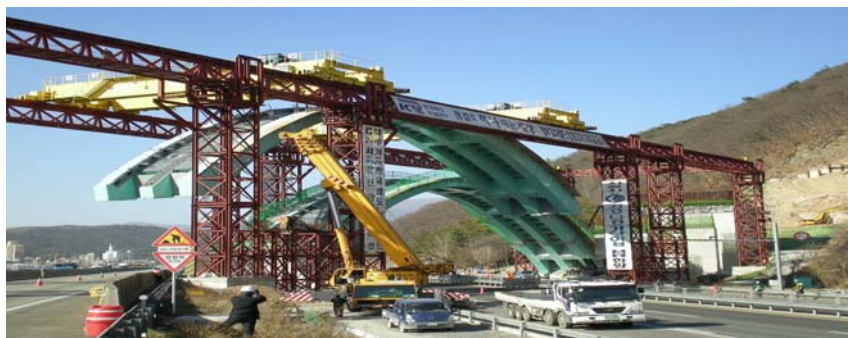
그림14 가설트러스를 이용한 오버헤드크레인 가설런칭공법
