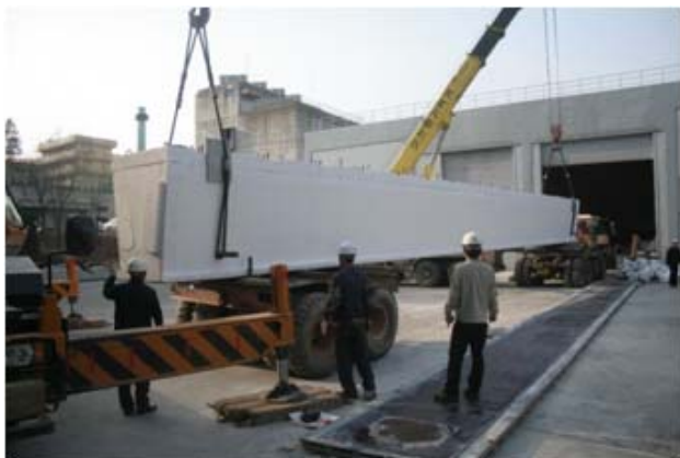
그림 28. 거더 시스템 인양
