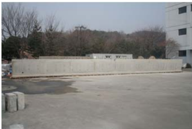
그림 22. 긴장전 거더 전경
