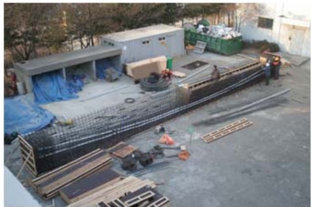
그림 15. PSC-U형 거더 철근 및 거푸집 전경
