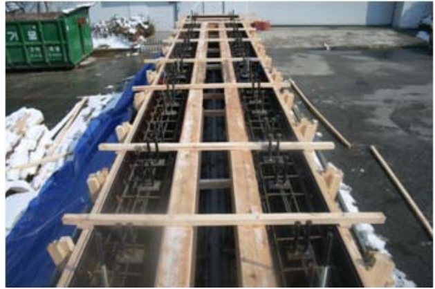
그림 17. 전단스터드 설치
