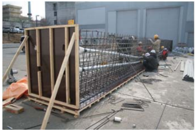
그림 13. 쉬스판 설치
