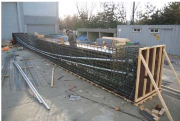
그림 14. 내부 거푸집 설치
