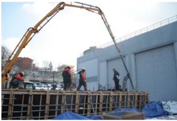
그림 18. 콘크리트 타설
