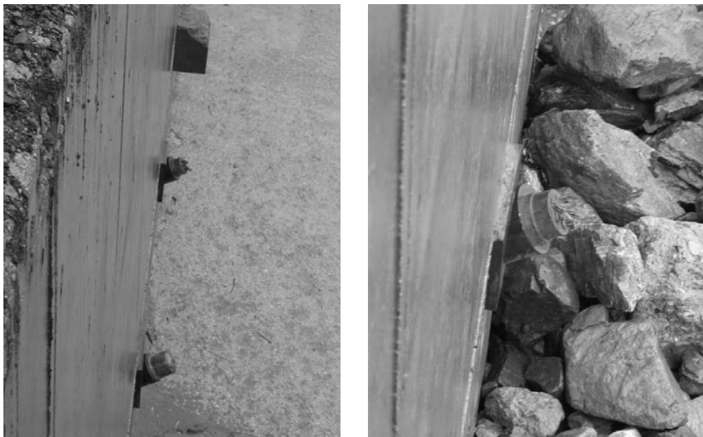
그림 10 앵커두부의 캡 파손으로 인해 앵커 두부가 노출되어 부식된 사례
