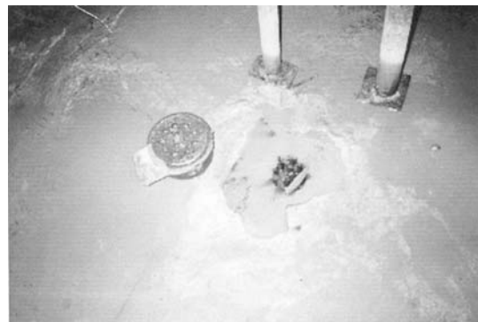
그림 8 앵커 두부의 방식 미흡으로 부력방지 영구앵커의 강연선이 부식·파단한 상태
