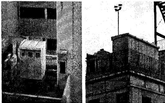
〈그림 9〉 건물 옥상에 시설된 일체형 및 큐비클식 수변전실비
