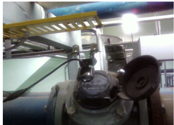
그림 5 유량계와 카메라 설치(중부화력)
