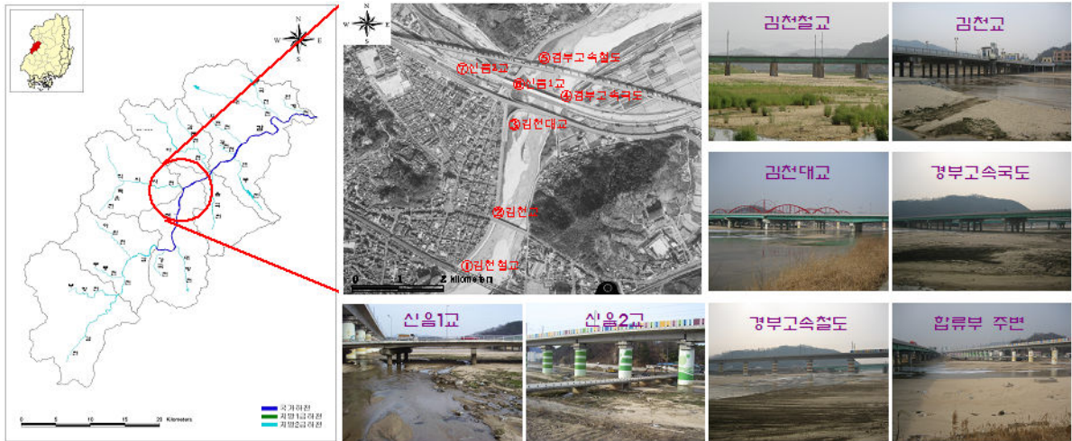
그림 1. 대상 구간내 교량현황(항공사진, 2004)
